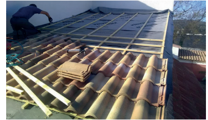
4ème étape: mise en place des tuiles
