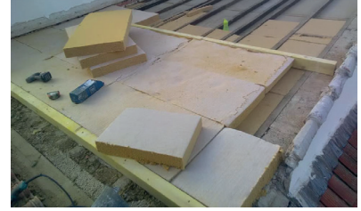
2ème étape: mise en place d'une seconde couche de fibre de bois entre chevrons dans l'autre sens par rapport à la 1ère couche
