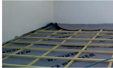
3ème étape: mise en place d'un écran sous-toiture et du contre-lattage
