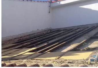
1ère étape: mise en place d'une première couche de fibre de bois entre chevrons
